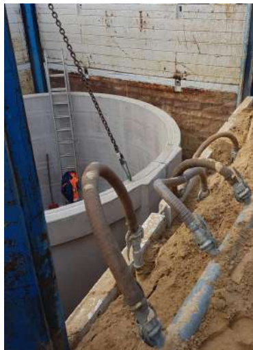
Einbau des neuen Vorlagebehälters inklusive Wasserhaltung
