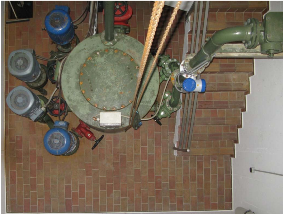
Umbau der RÜB Lauterbach
