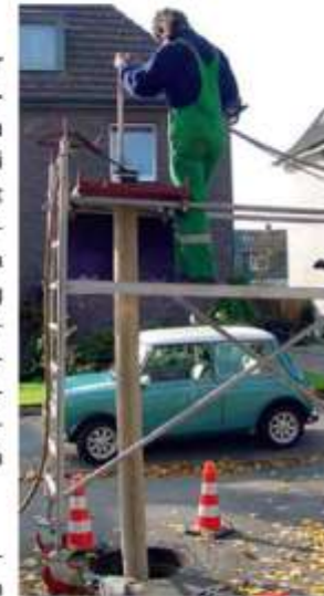
Sanierung von Wurzelschäden: Ein Schlauchliner wird vom Hauptkanal aus eingezogen. Der Linner selbst ist wurzeldicht.
