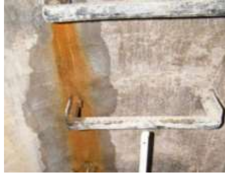
An Einbindung Bügel undicht
