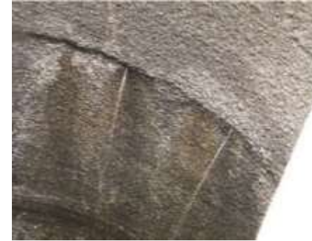
Undichtigkeit Beschichtung
