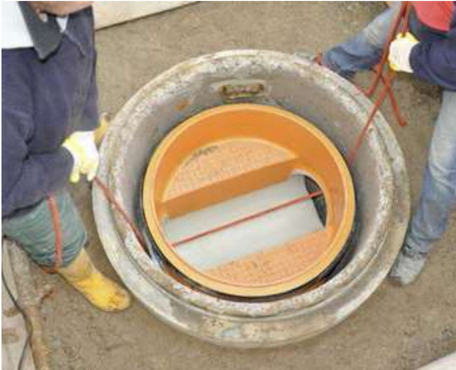
Montieren der Dichtung und Ablassen des Unterteiles
