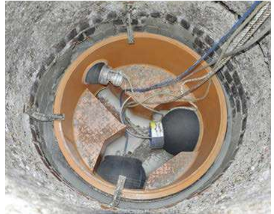
Einstecken d. Absperrblasen fixieren des Schachtunterteiles
