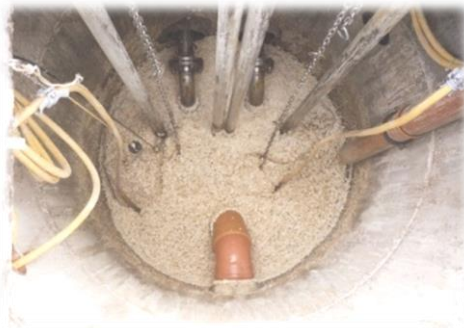
Amorphes Abdecksystem im Pumpwerk
