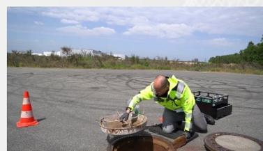
3. Schachtdeckel öffnen und Schmutzfänger entfernen.
