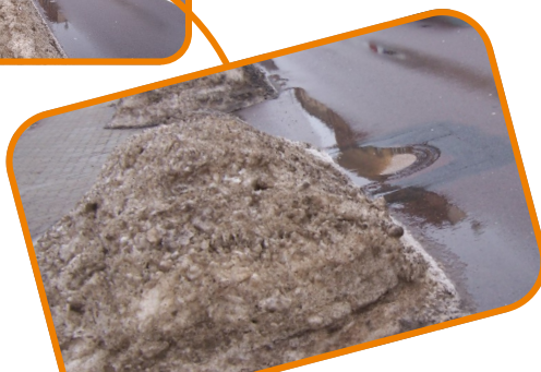
gefrorener Oberflächenfremdwasserzufluss über Schachtdeckelfuge und Nutzen im Winter
