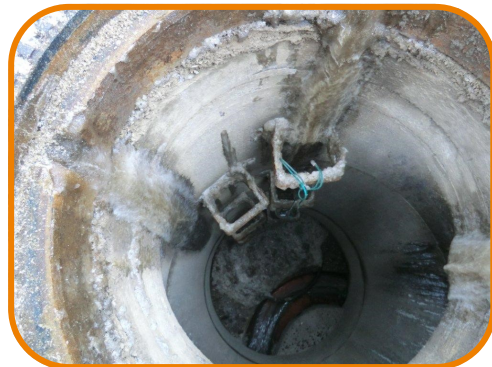
gefrorener Oberflächenfremdwasserzufluss über Schachtdeckelfuge und Nutzen im Winter
