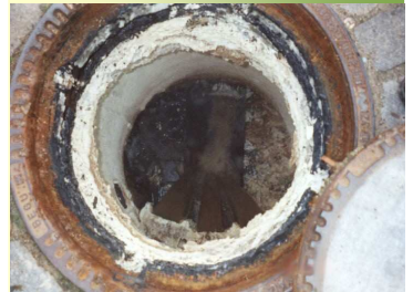
Kanalschacht ohne Korrosion:
