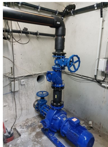
Integration der neuen Pumpen in den ehemaligen Aufstellraum
