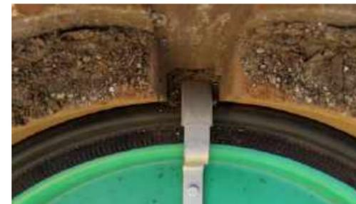
**5.** Auflage des Haltekreuzes in den Einhängenuten des Schachtdeckelrahmens und richtigen Sitz der Randdichtung überprüfen
