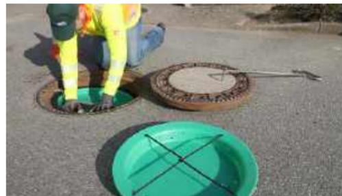
**4.** Uni-AdSorber mit etwas Kraft in den Schachtdeckelrahmen drücken, es muss dabei mindestens ein Haken des Haltekreuzes in einer der Nuten des Schachtdeckelrahmes sitzen
