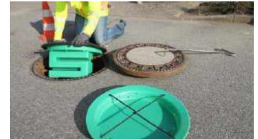
**3.** Geruchsdämpfungs-System mit leichter Kippbewegung einsetzen (Filterkasten entgegengesetzt der Steigisen)
