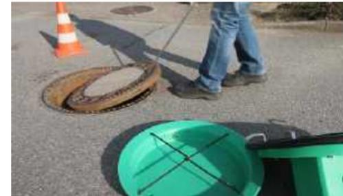
**2.** Schachtdeckel öffnen und Schmutzfang entnehmen (Schmutzfang wird nicht mehr benötigt)
