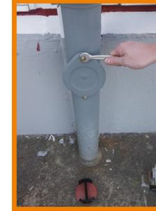
Schrauben der Revisionsklappe
