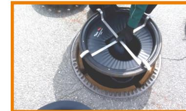
Fremdwasserverschluss-System mit leichter Kippbewegung einsetzen
