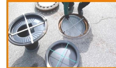
Schachtdeckel öffnen und Schmutzfang entnehmen (Schmutzfang wird nicht mehr benötigt)
